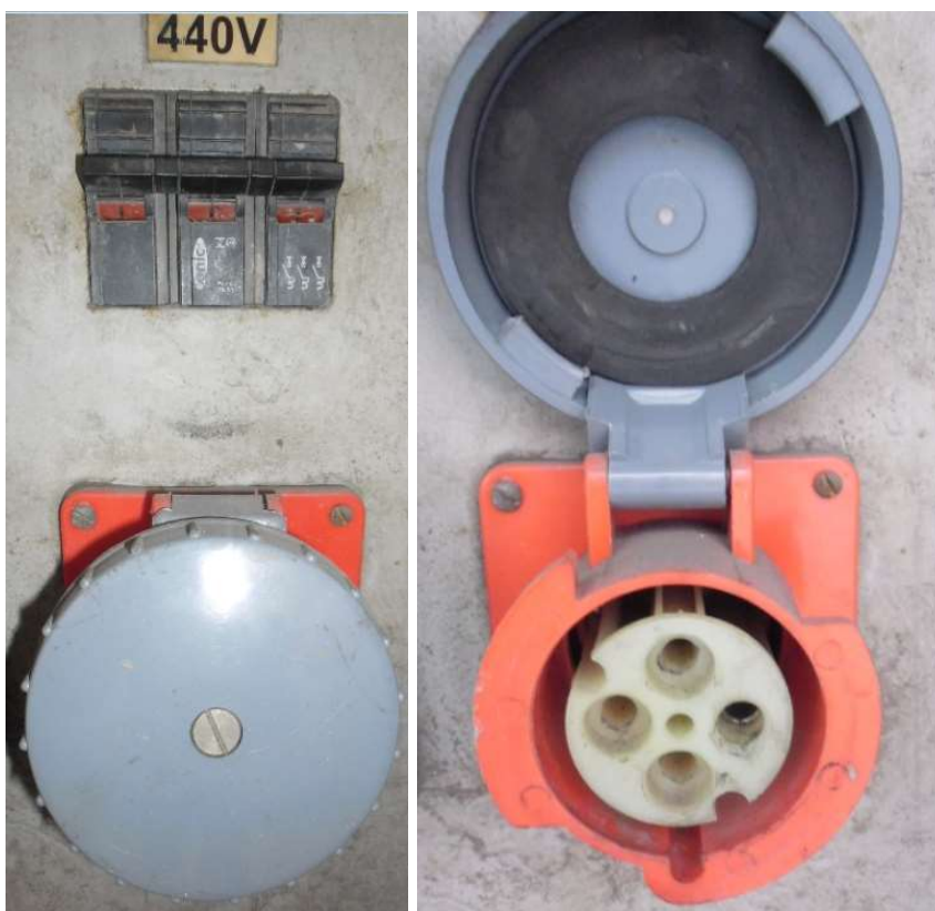
Quadro de força
